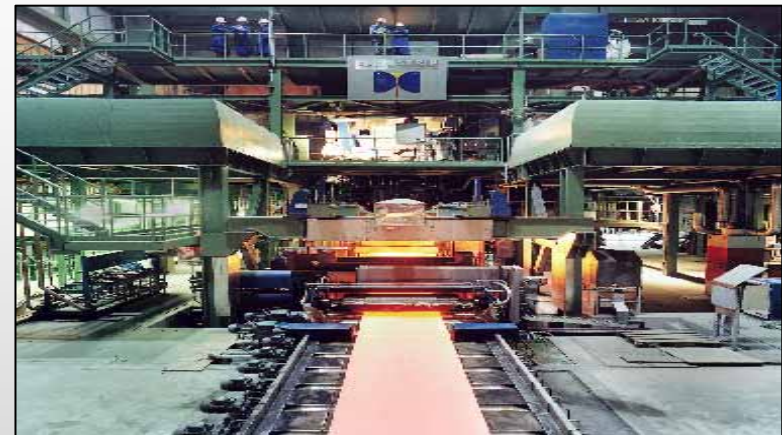
Bandgießanlage, Thyssen Krupp, Krefeld
